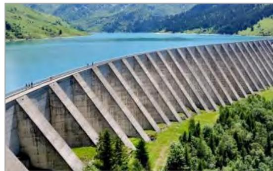
Barrage à contreforts : le mur du barrage est conforté par tout un ensemble de structures, en contrefort.
